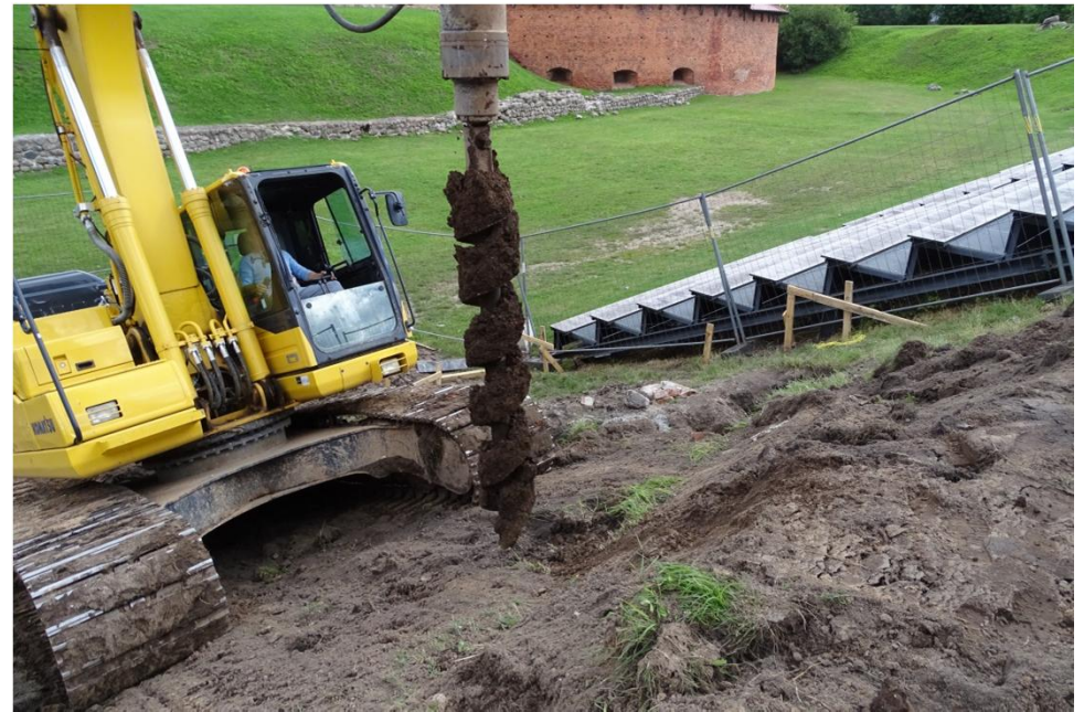
foto 16. B polių eilė. Polio Nr. 12 gręžimas. Foto iš PV.
